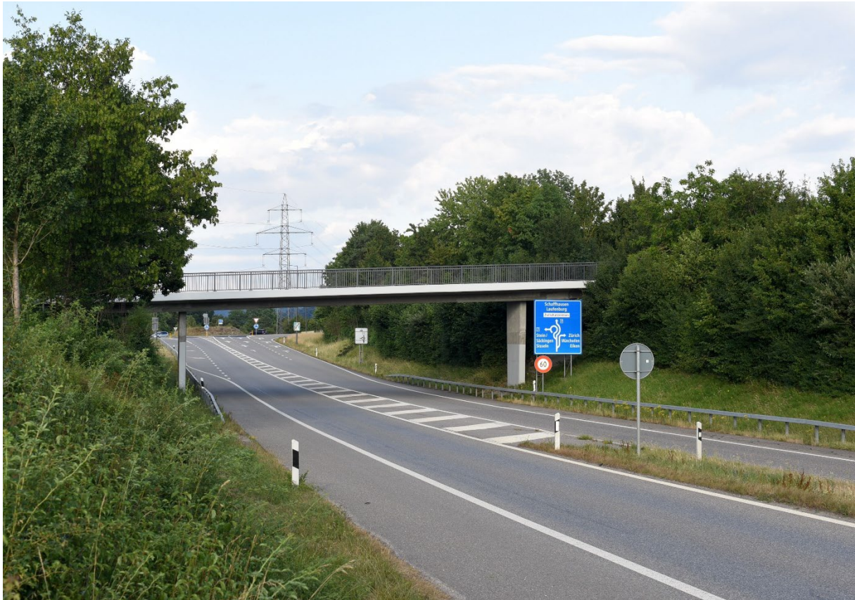
Beginn der Expressstrasse E7 in Eiken Richtung Laufenburg mit der acht Meter breiten Brücke, welche kaum genutzt wird
