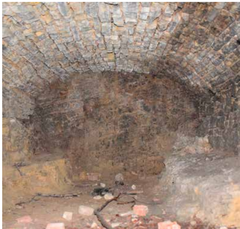
Ehemaliger Bierkeller an der Seckenbergstrasse. (Foto: Urs Berger, 2019)
