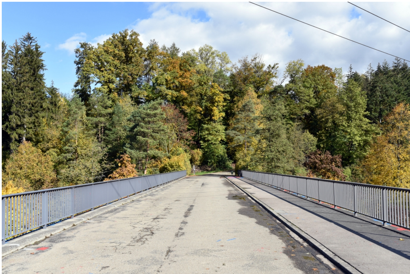
Die grosszügige acht Meter breite Ehlenbergbrücke führt über Autobahn und Sissle.
